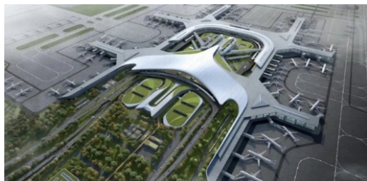
上海浦东国际机场四期扩建工程
