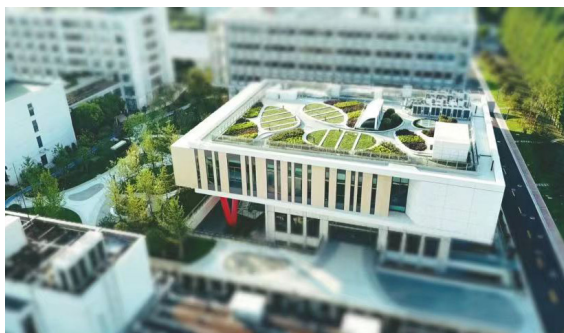
上海建科集团莘庄园区
